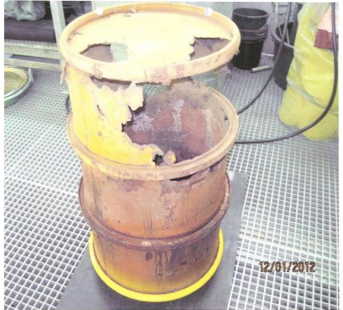
Rostfass Kaverne Brunsbüttel
